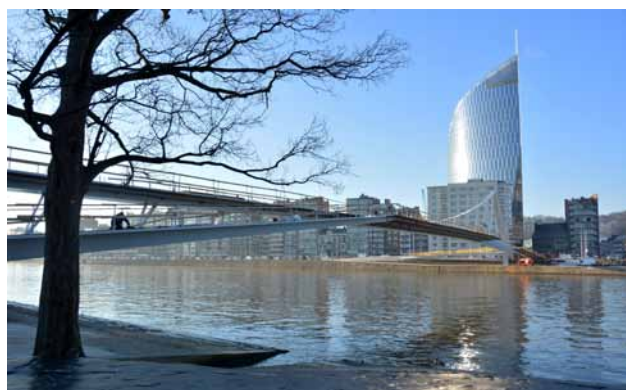
Passerelle de la Boverie © JP Ers, Ville de Liège
