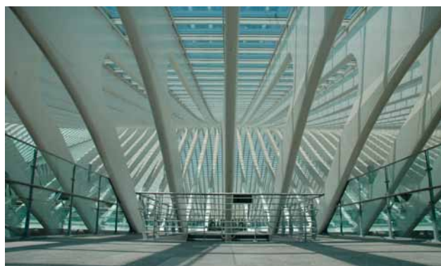
Gare des Guillemins (arch. Calatrava) © JP Ers, Ville de Liège
